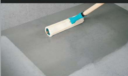
3. Aufbringen der Grundierung ALSAN 170
