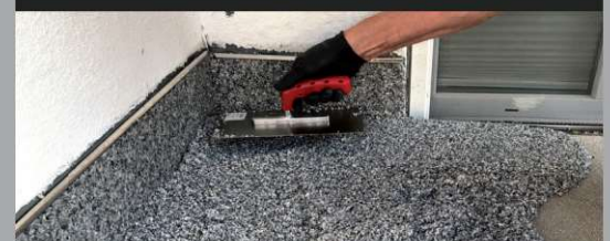
5. Aufbringen des Granulatgemisches ALSAN 817 Bindemittel / ALSAN 887 Marmorkiesel
