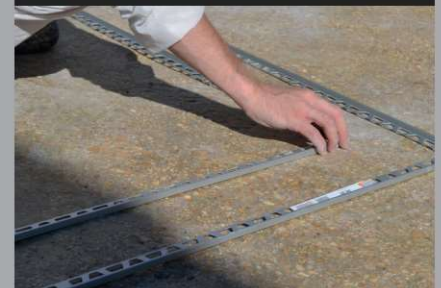
2. Aufbringen von Eingrenzungsprofilen und Treppenkantenprofilen
