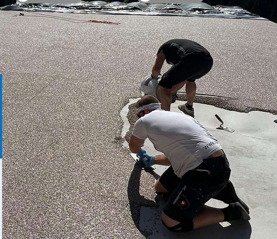
1. Vorbereitung des Untergrunds
