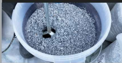
4. Vorbereiten des Granulatgemisches ALSAN 817 Bindemittel / ALSAN 887 Marmorkiesel
