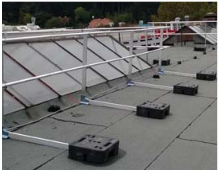
Das Auflast gehaltene Geländersystem aus Aluminium gewährleistet die Sicherheit bei Wartungs- und Pflegearbeiten auf nicht-öffentlich genutzten Flachdächern. Barrial selbsttragend erfüllt alle gesetzlichen Anforderungen zum permanenten und kollektiven Schutz vor Absturz optimal.
